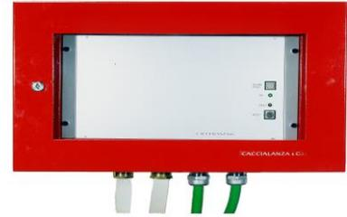
Das CMT2 oder CMT21 Kabel dient dem Aufbau der Hauptschleife zur Verbindung aller Einheiten, während das CMT3 Kabel für die Verbindung der zwei UZM and UZA Schränke und von da ab für die Verbindung zu/von den Aktoren verwendet wird.
